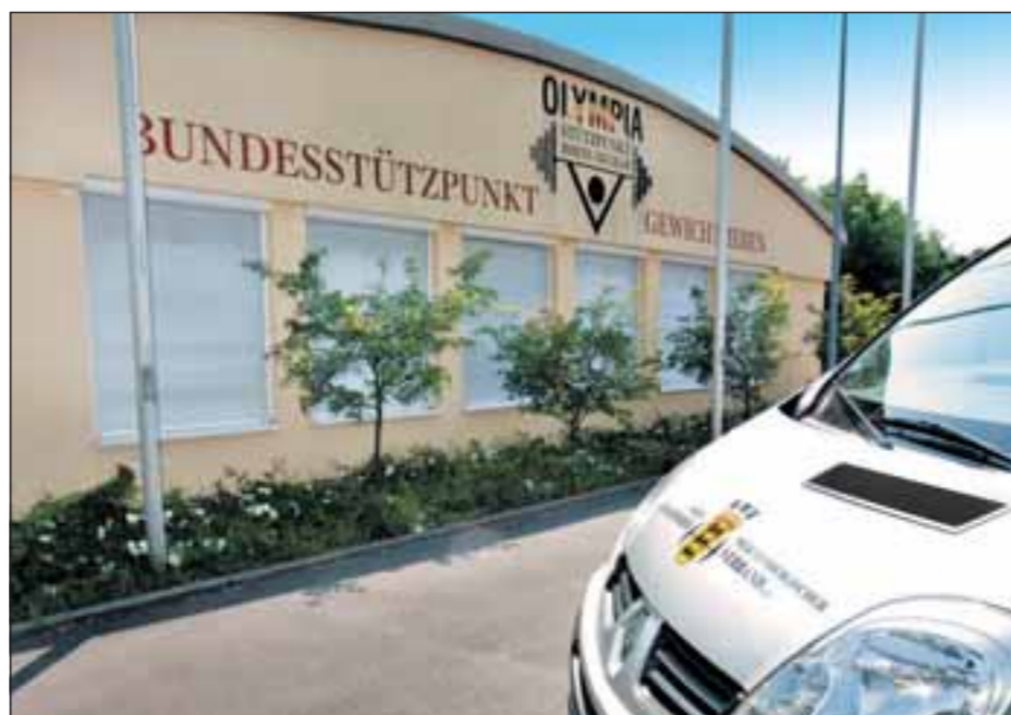
Außen hui, innen pfui: Das BLZ in Leimen soll jetzt saniert werden. Foto: Alex
